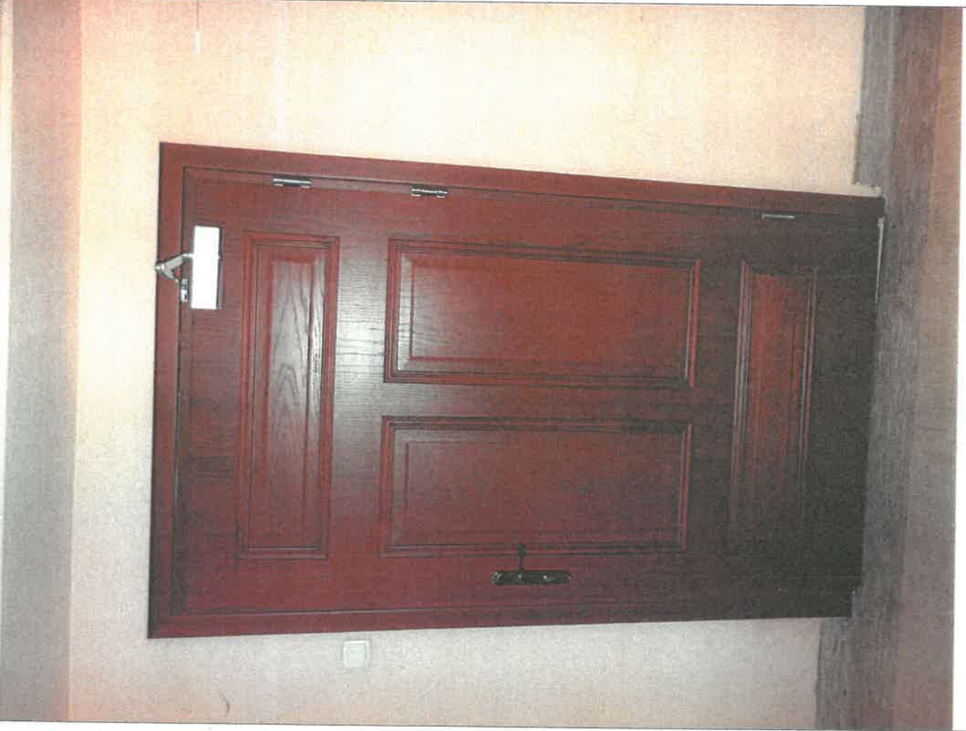
Rys. nr. 8 Wzór drzwi stylowych do sali chorych i biura działu AE (drzwi z drewna litego o odporności ogniowej EI30).
